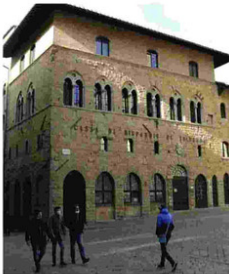
La sede centrale della Cassa di risparmio di Volterra in piazza dei Priori
