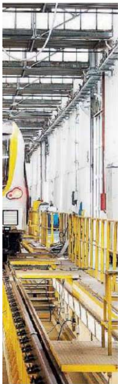
Il cantiere di Torre Lupu
